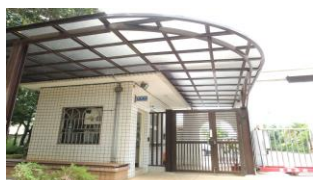
警衛室旁增設雨棚
